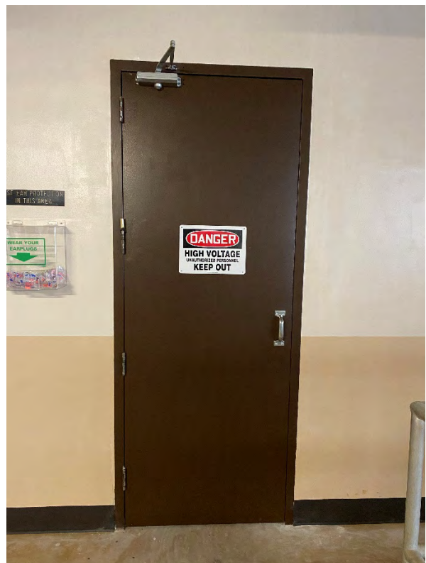
MCC Door Modification
